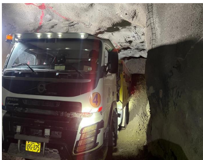
Fotografía 04: Volquete de Descarga Horizontal en proceso de descarga de CRF en el Top Cut.
