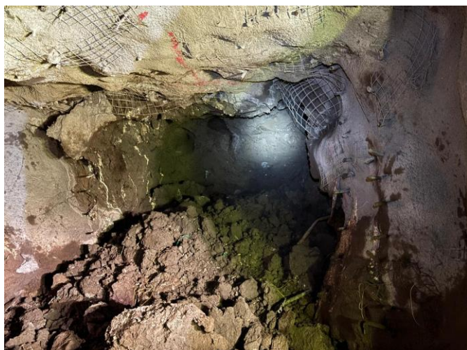
Fotografía 02: Prueba Piloto de inyección de resina a alta presión en roca tipo V.
