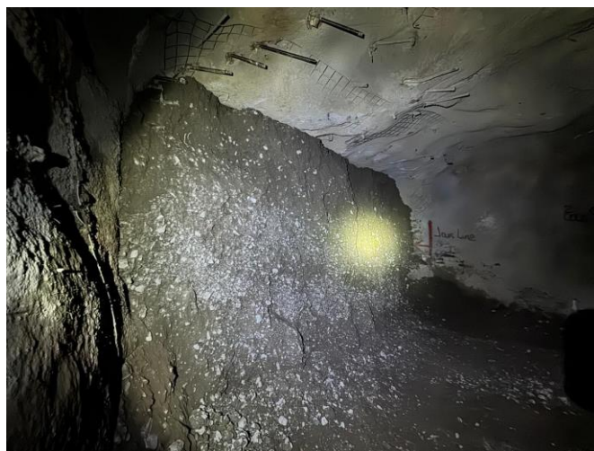
Fotografía 04: Talud 90° del proceso de backfill
