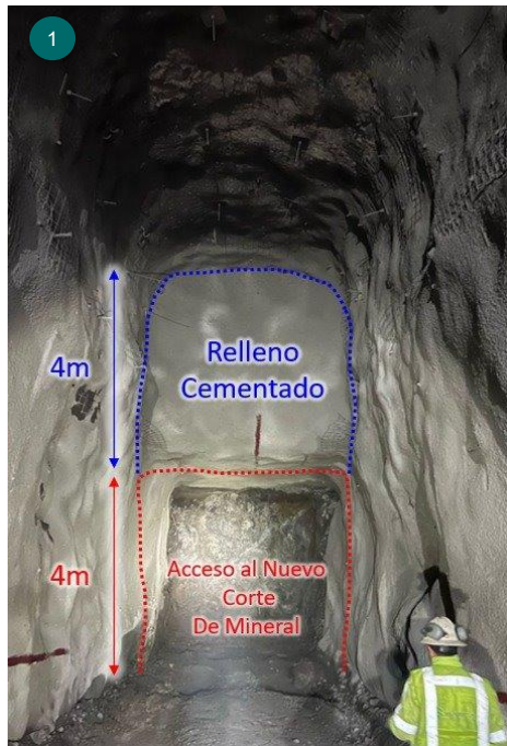
Fotografía 01: Vista del Top Cut relleno con CRF y el ingreso al piso -1. El punto 01 indica de manera referencial la zona de la fotografía en la gráfica 04.
